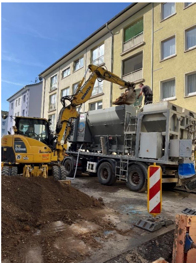
Abbildung 1: Herstellung von LIQUID GROUND mittels der mobilen Mischanlage im innerstädtischen Bereich
